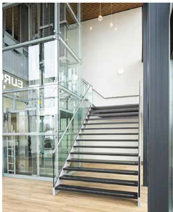
De hoofdtrap maakt halverwege een draai van 90° rondom de aanwezige glazen liftkoker.
