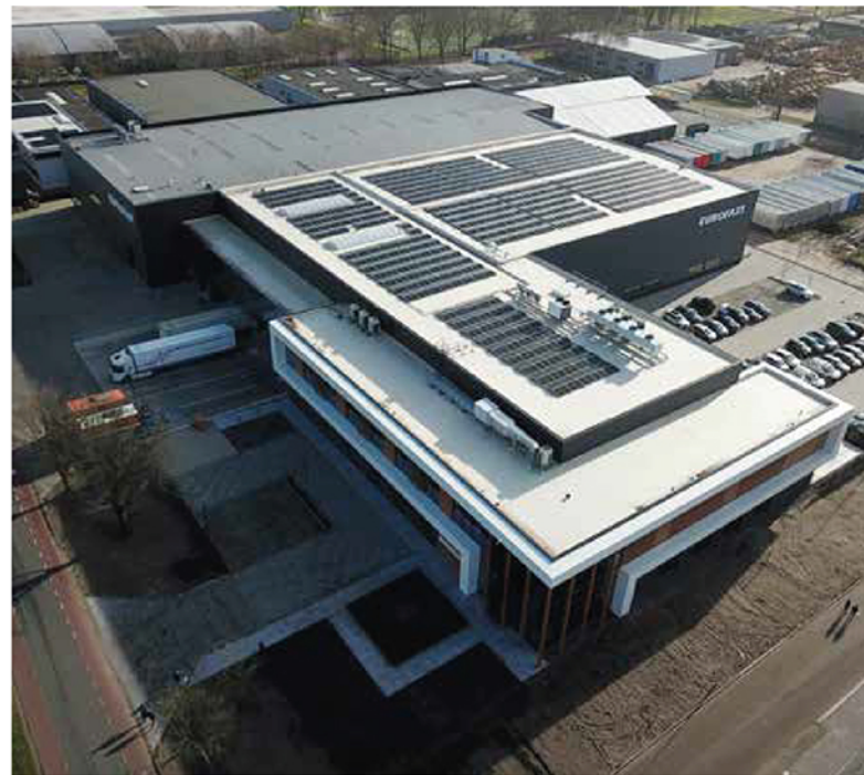
De witte dakbedekking zorgt voor een betere opbrengst van de zonnepanelen.
