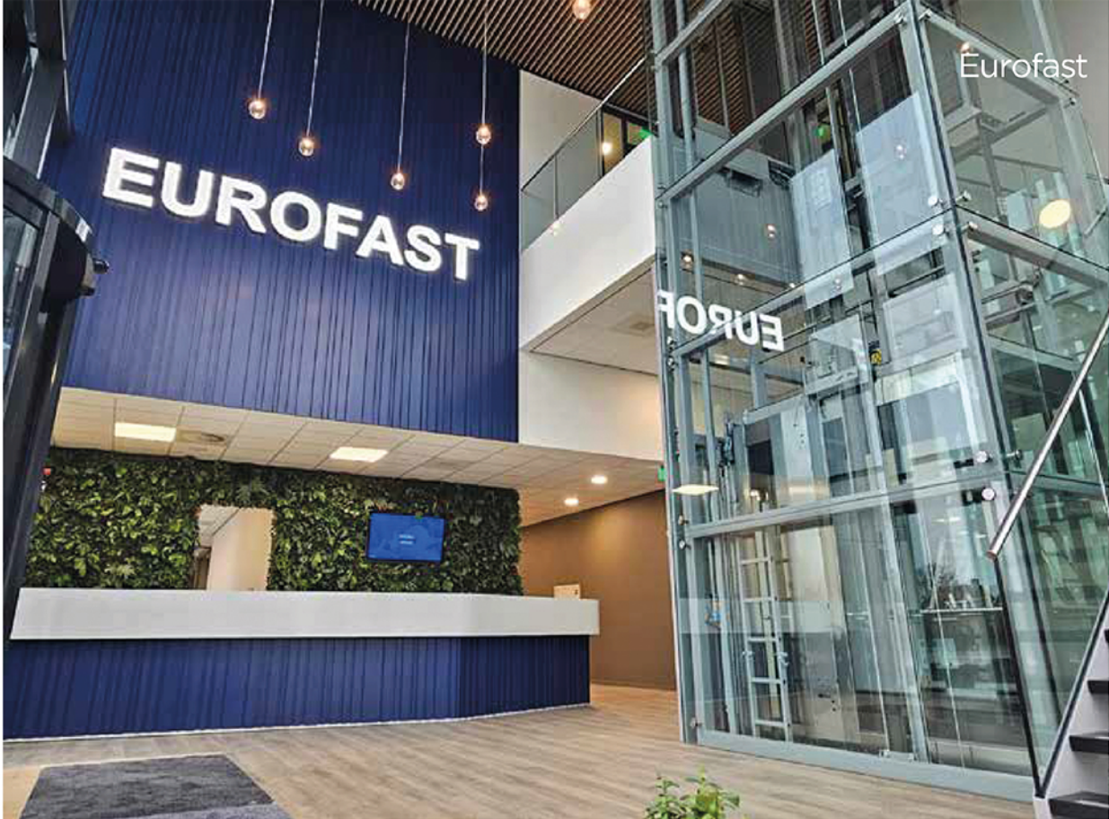
Tegen de wand boven de receptie is aluminium gevelbekleding aangebracht, inclusief een verlicht bedrijfslogo.
