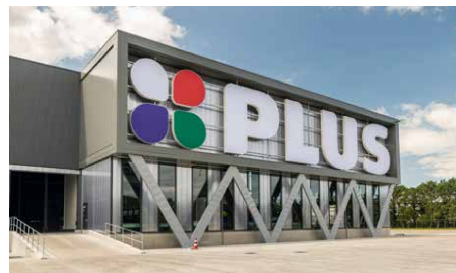
Op industriegebied Vorstengrafdonk in Oss heeft Bouwbedrijf van de Ven een distributiecentrum van ruim 46.000 m 2 gebouwd voor PLUS.
