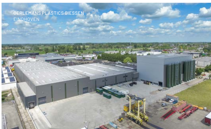
DE HAL HEEFT EEN KOLOMVRIJE OVERSPANNING VAN MAAR LIEFST 55 METER.
